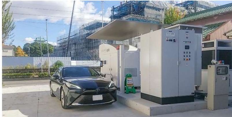
名古屋城グリーン水素ステーション
